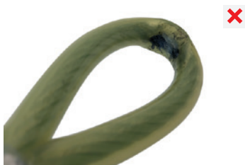
narušená konstrukce prameny ocelového lanka
